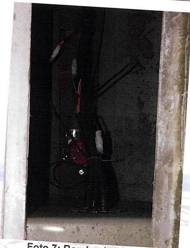
**Foto 7: Bomba de esgoto.**
