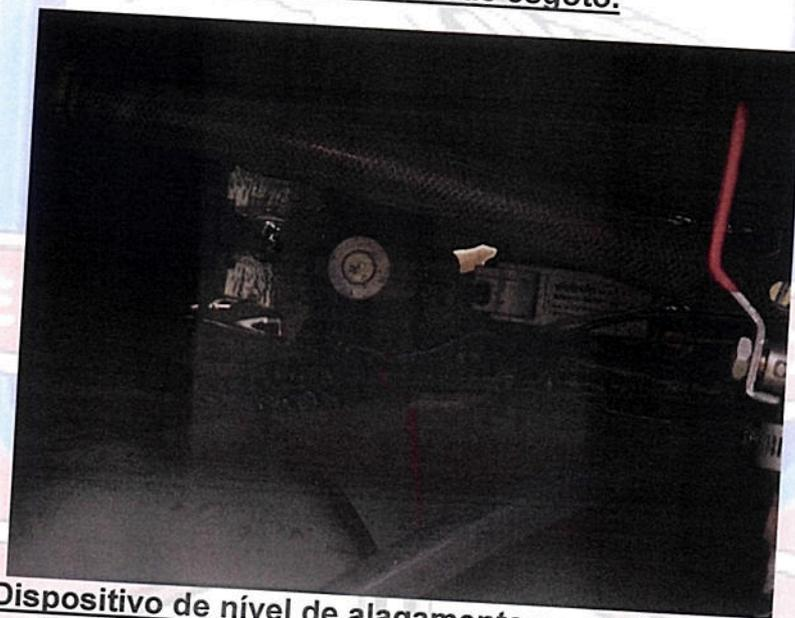
**Foto 8: Dispositivo de nível de alagamento para ativação do alarme sonoro.**
