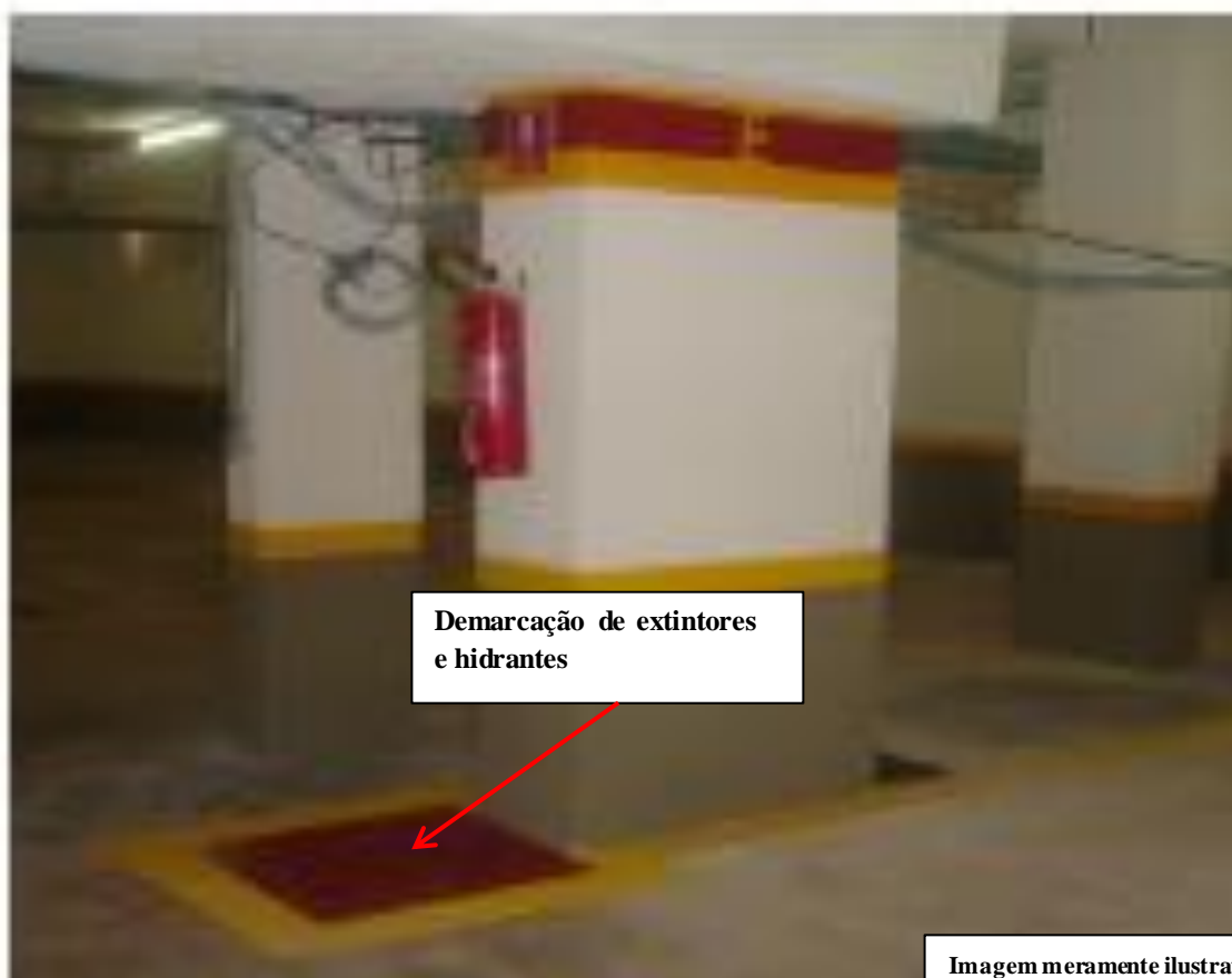
Imagem 3: Demarcação de extintores e hidrante.
