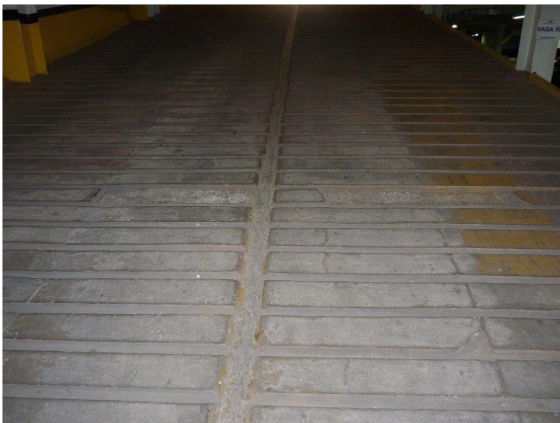
Imagem 4: Rampas de acesso.
