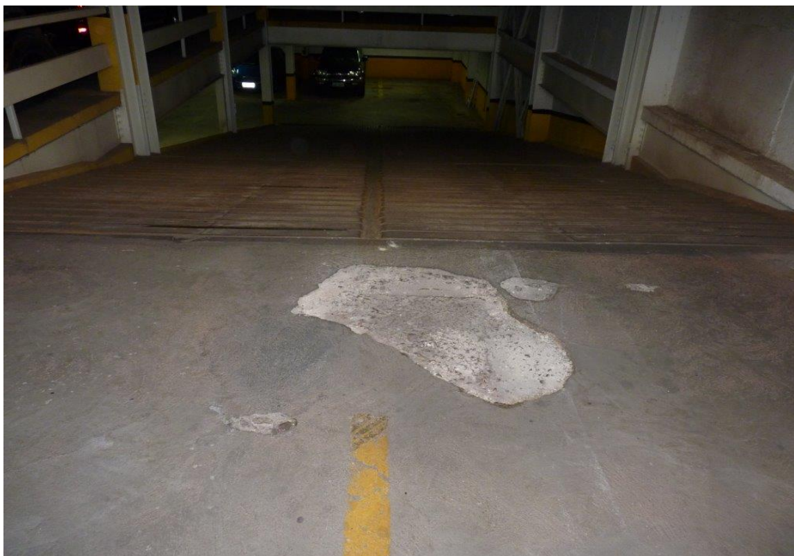
Imagem 3: Rampas de acesso.
