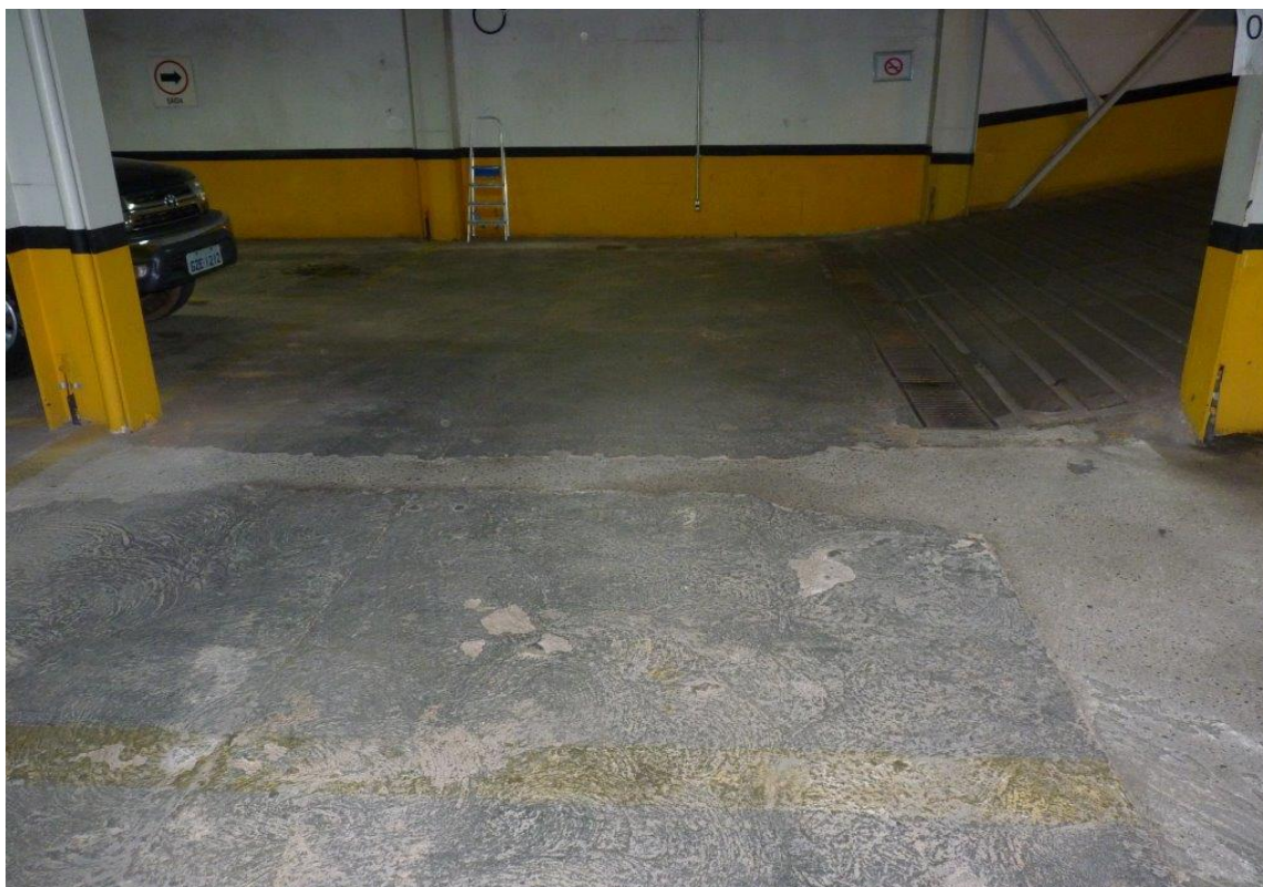
Imagem 5: Final das Rampas de acesso.
