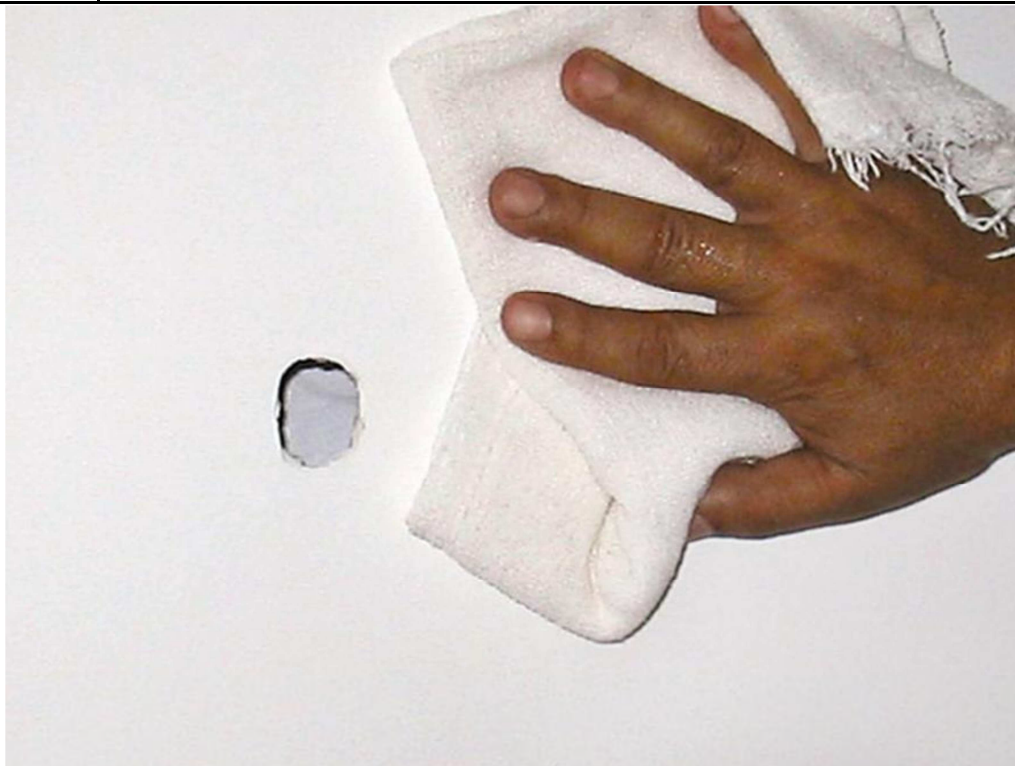
Foto 3 - Limpeza da área a ser reparada
