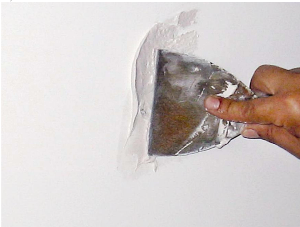
Foto 4 – Preenchimento do furo ou abertura com massa adesiva MAP.
