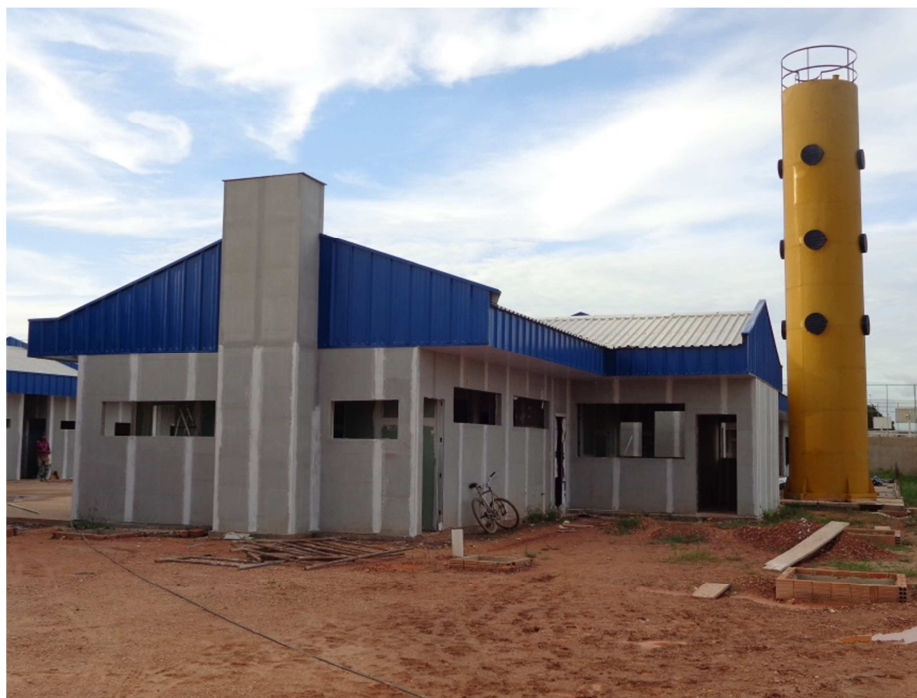
Foto 2 – Creche/escola com placas cimentícias (fechamento externo antes do acabamento final)
